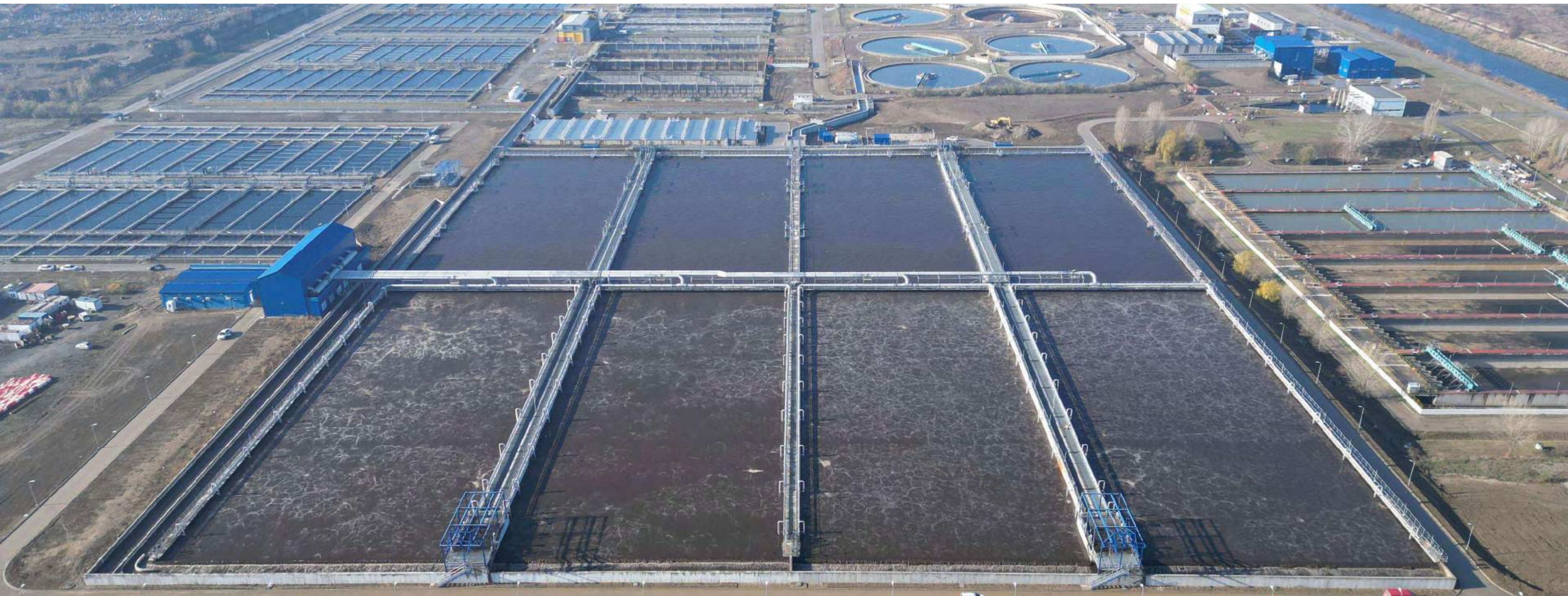
Planta depuradora de Glina, Rumanía
