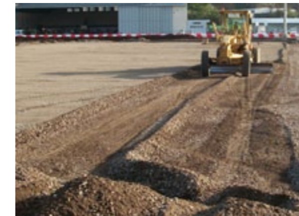
Extendido y nivelado de zahorra de hormigón machacado.
