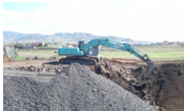
Acopio de fresado de aglomerado asfáltico.
