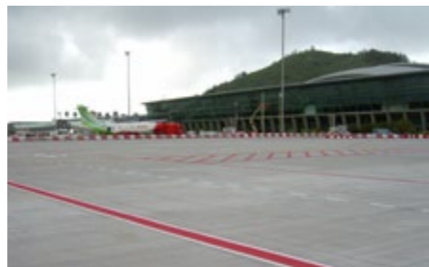
Plataforma de hormigón lista para entrega y puesta en servicio.
