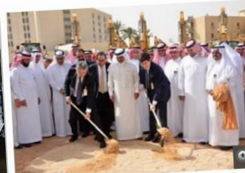
Jaime Freyre, presidente del consorcio que lidera FCC (derecha) en el inicio de las obras del metro de Riad
