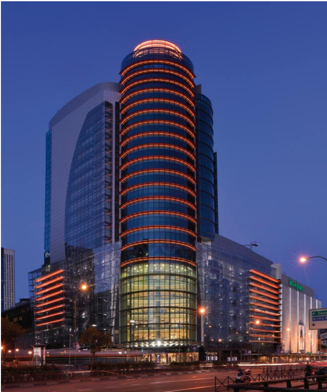
Edificio Torre Castellana, Madrid
