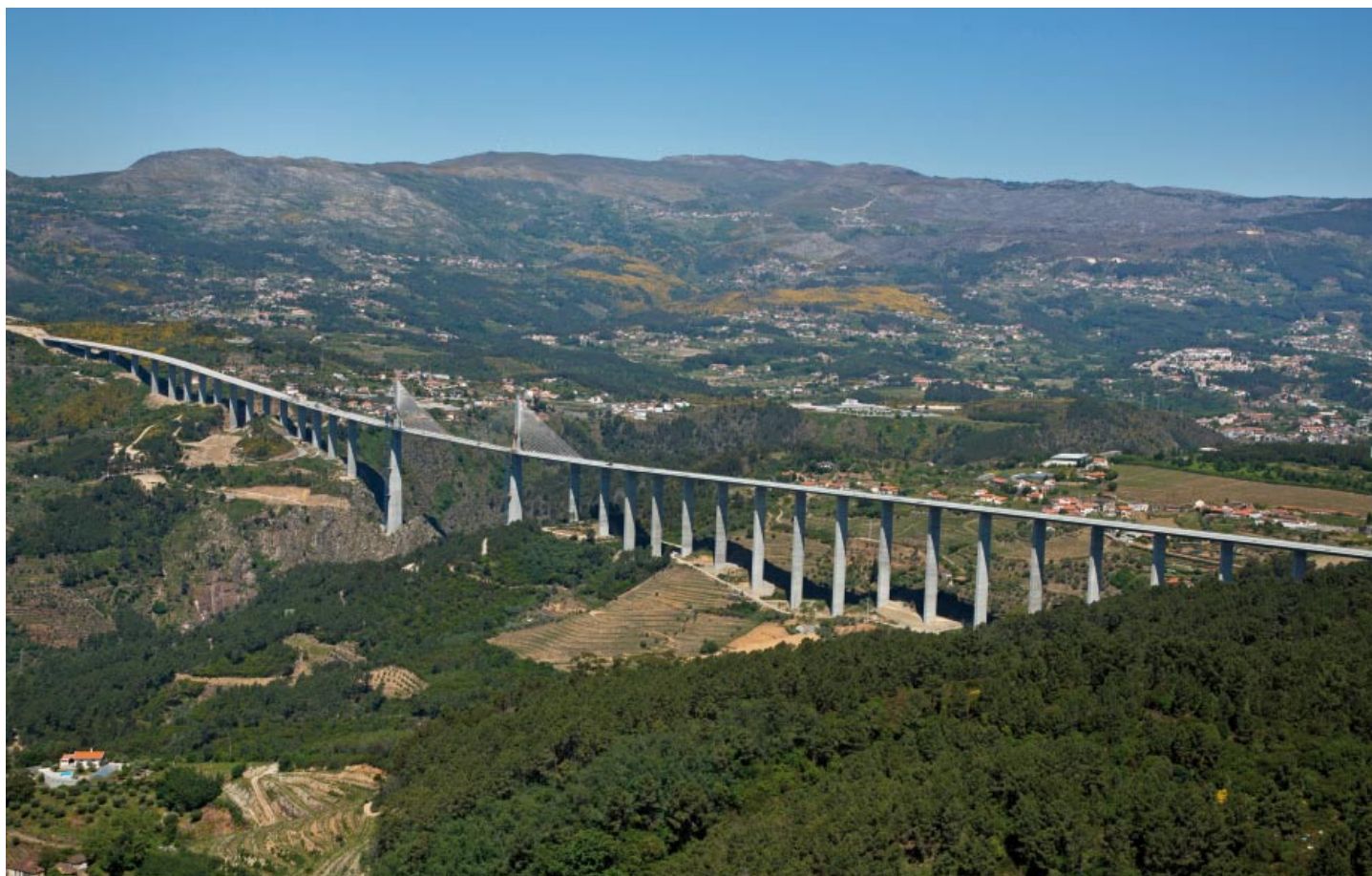
Viaducto do Corgo de la Autopista Transmontana, Portugal
