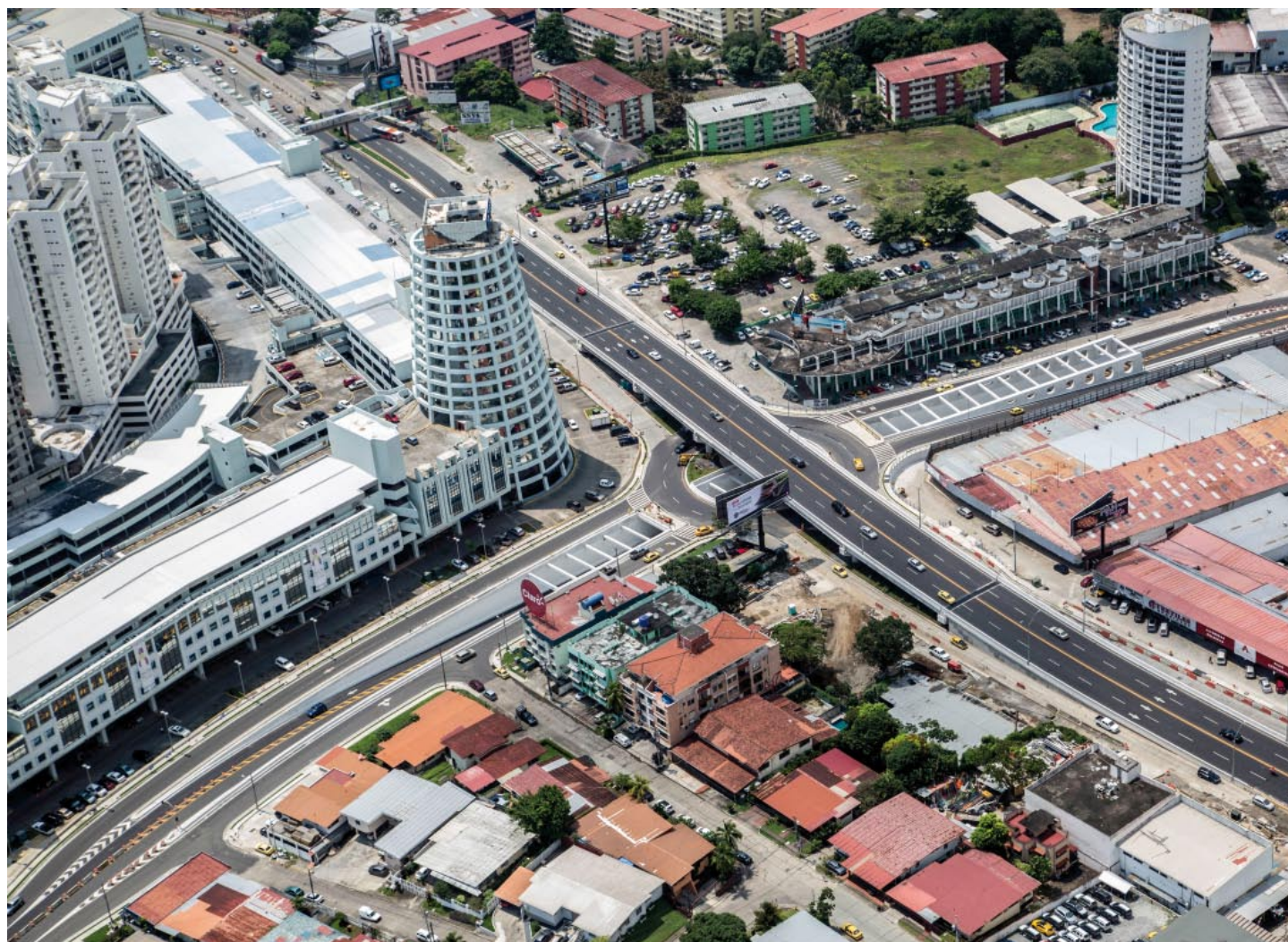
Proyecto Corredor Vía Brasil Tramo 1
