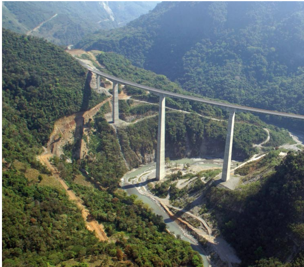
Viaducto de San Marcos, México
