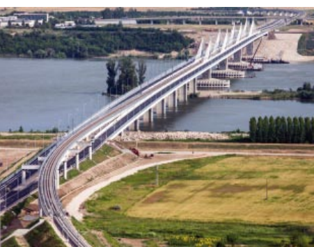
Puente sobre el Danubio
