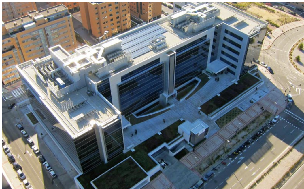
Sede central FCC Construcción. Las Tablas, Madrid
