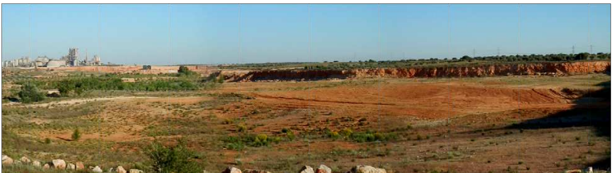
Restauración de la Plaza de cantera
