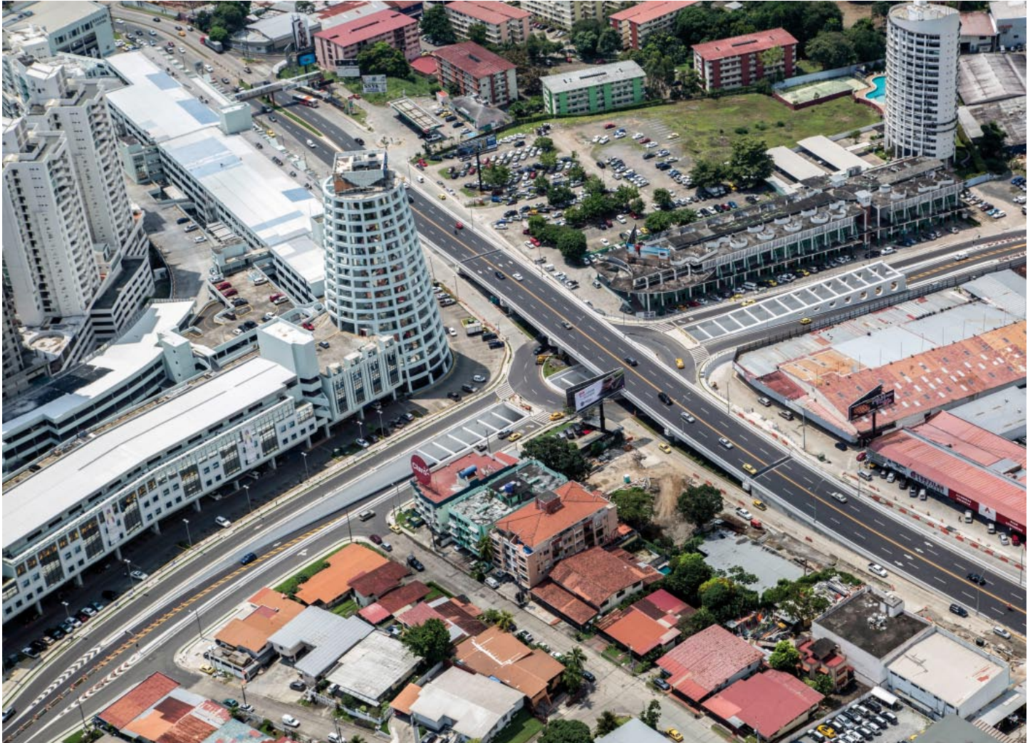
Vía Brazil Corridor Project Section 1, Panama
