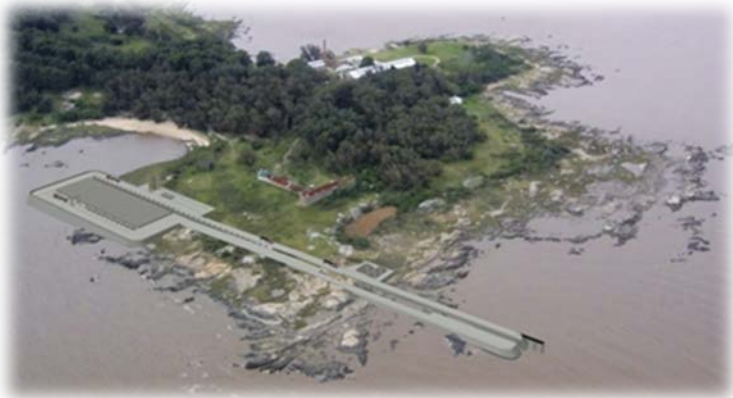
Transmarine pipeline (Uruguay)
