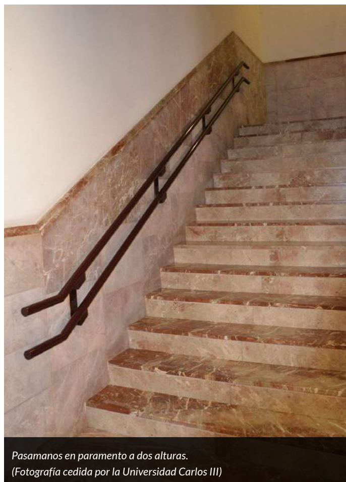
Pasamanos en paramentos a dos alturas y elemento de protección lateral en borde libre. (Fotografía cedida por la Universidad Carlos III)
