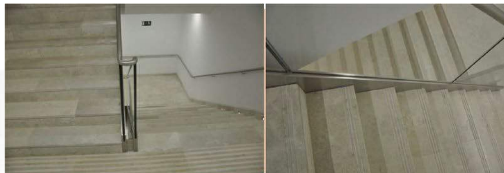
Pavimento podo-táctil en huella de escaleras, y mesetas de desembarco escaleras
