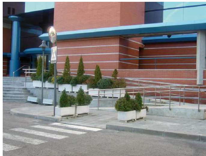
En el itinerario accesible se visualiza el paso de peatones, que conduce al vado peatonal de un único plano, y la rampa exterior con pasamanos a dos alturas. (Fotografía cedida por Acciona)
