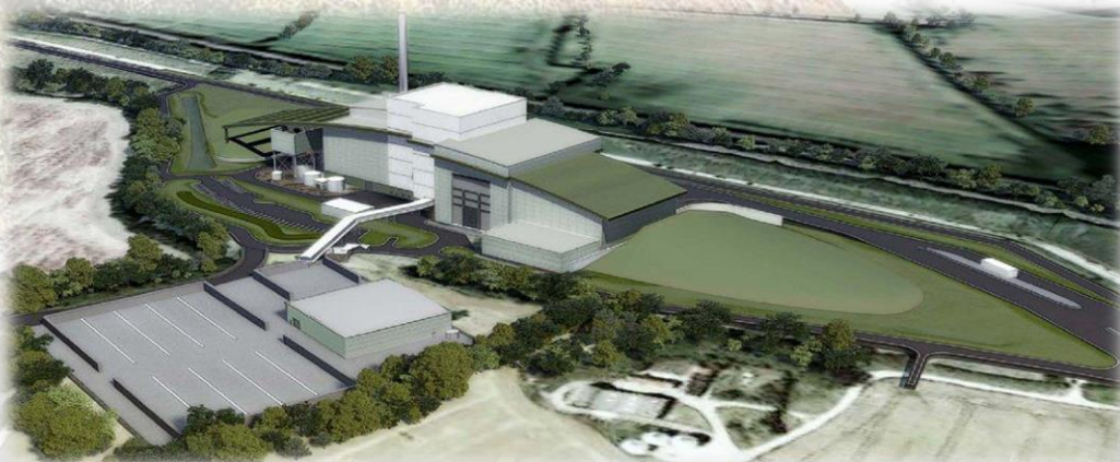
Construcción del Centro de Tratamiento de Residuos de Buckinghamshire (EfW)
