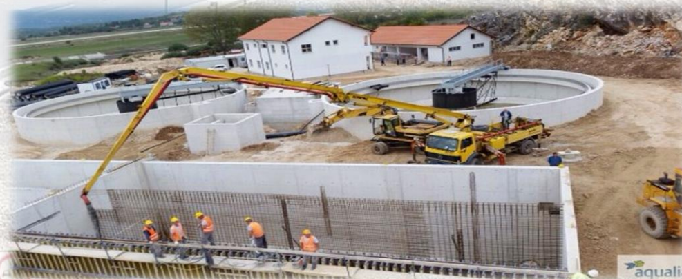
EDAR de Pljevlja (Montenegro)
