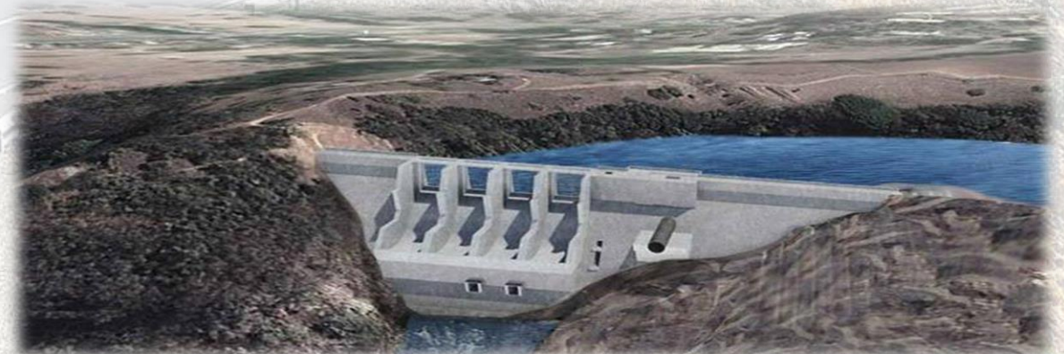
Hidroeléctrica/ Presa de Chucas (Costa Rica)
