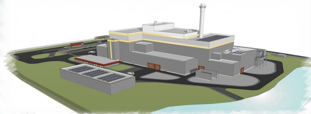
Próxima Planta de Reciclaje e Incineración (Edimburgo)
