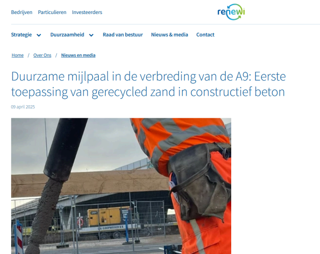
In opdracht van Rijkswaterstaat werkt consortium VeenIX aan de verbreding en verdiepte aanleg van de A9 tussen de knooppunten Badhoevedorp en Holendrecht. Hierbij is een belangrijke circulaire mijlpaal bereikt: voor het eerst in Nederland wordt gerecycled zand toegepast in constructief beton voor nieuwe A9-viaducten afkomstig uit de sloop van twee A9-viaducten. Dit is mogelijk dankzij de constante, hoge kwaliteit van het gerecyclede zand van Renewi.
